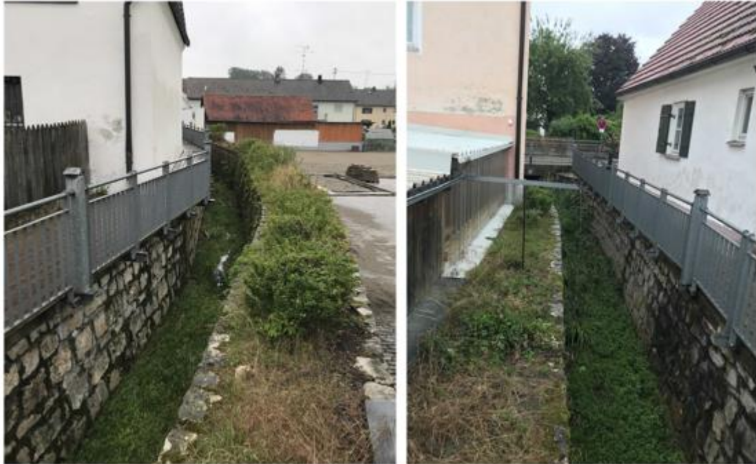
Abbildung 16: Weidener Graben (Vermessung Juli 2020, SC)
