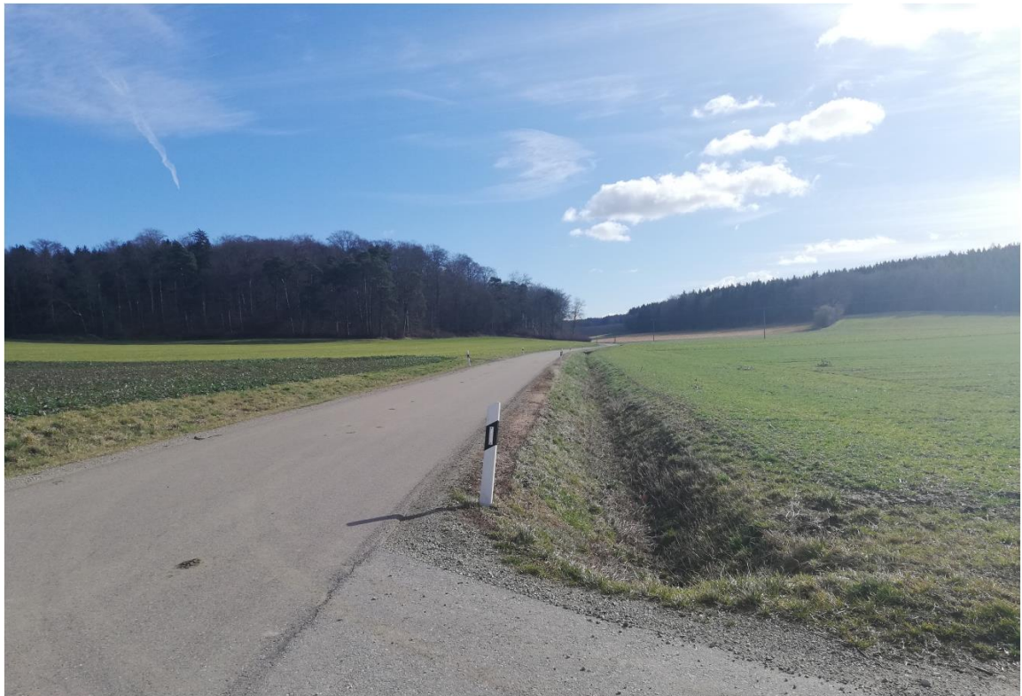
Abbildung 15: Graben entlang Weidener Straße
