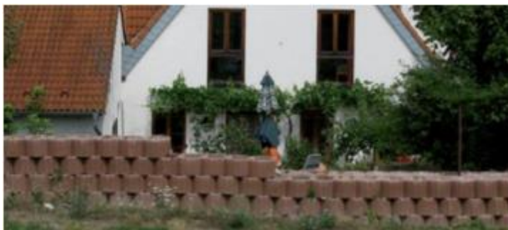
Abbildung 58: Mauer aus Flora-Wall-Steinen zum Schutz vor Außengebietswasser
