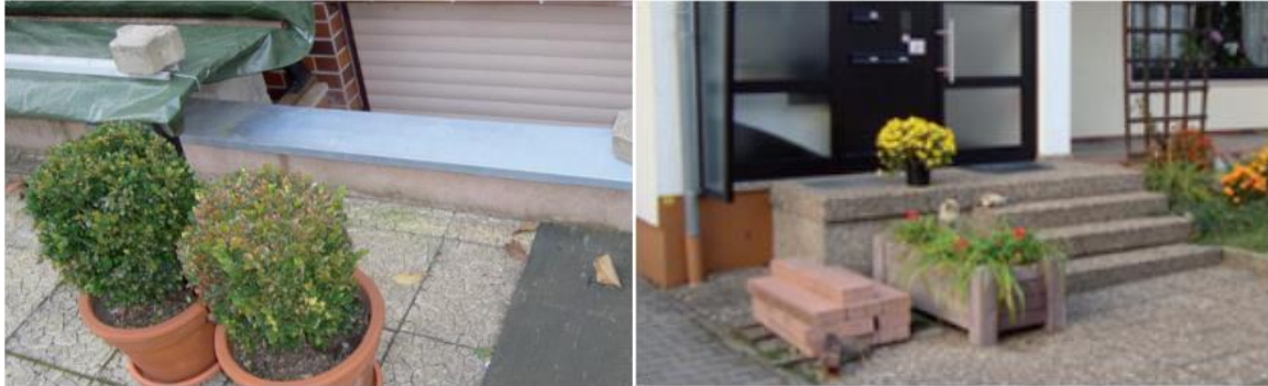
Abbildung 59 Hochgemauerte Kellerfenster und erhöhte Hauseingang
